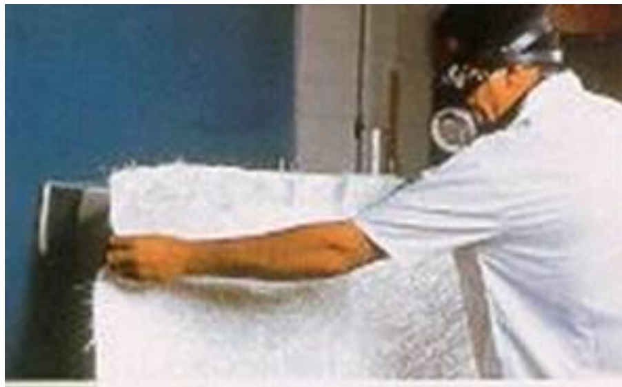
Colocação da Manta ou Tecido
