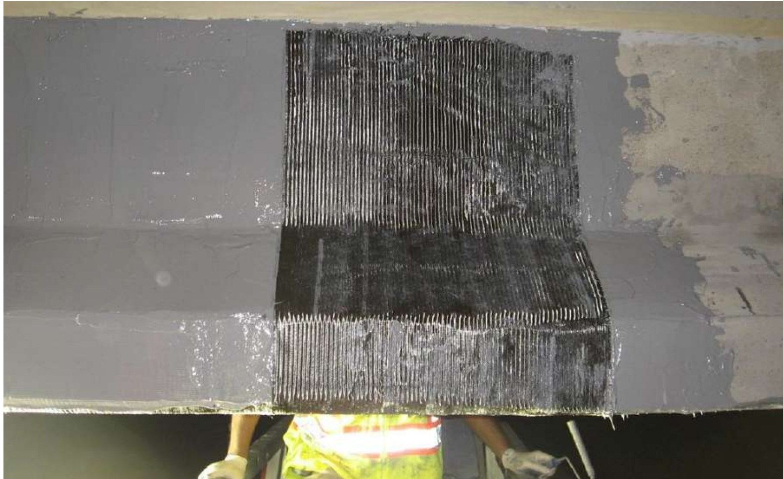
Laminação de Tecido Unidirecional
