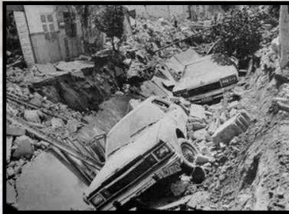
Explosão de galeria em Guadalajara
