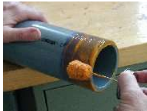
Reaplicar cimento para DE do tubo
