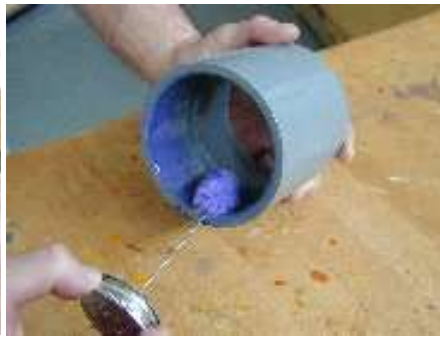
Aplicar ativador para DI da conexão
