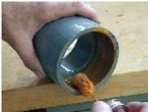
Aplicar cimento to DI da conexão
