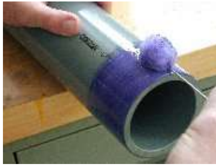
Aplicar ativador para DE do tubo
