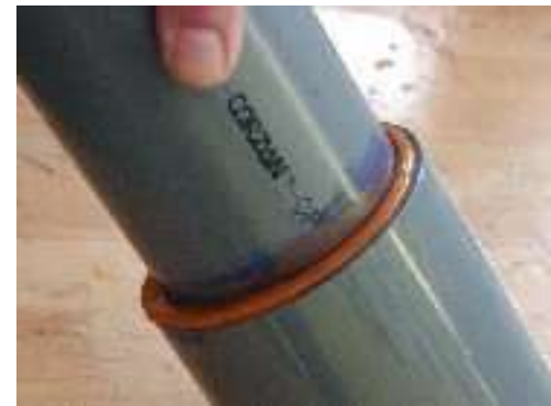
Colocar tubo dentro da conexão
