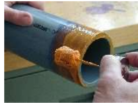
Aplicar cimento to DE do tubo
