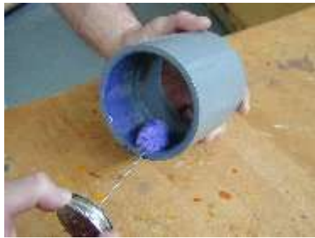
Aplicar o ativador para DI da conexão
